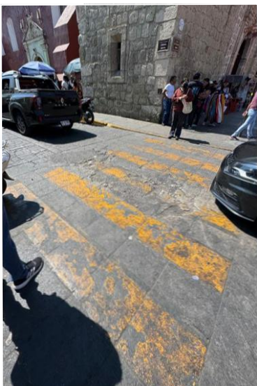
Perdida de material en arroyo vehicular de concreto
