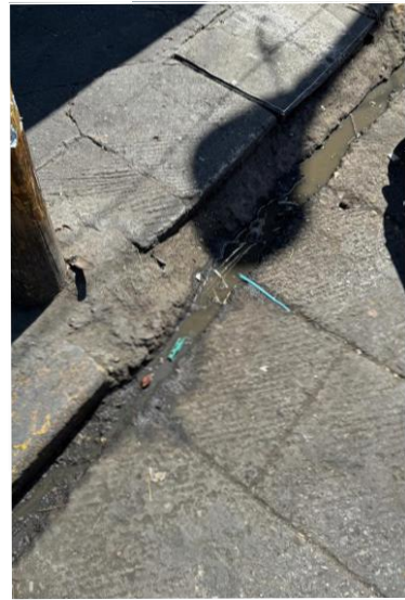
Perdida de material en guarnición de concreto
