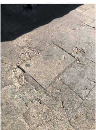
Grietas en banqueta de concreto estampado
